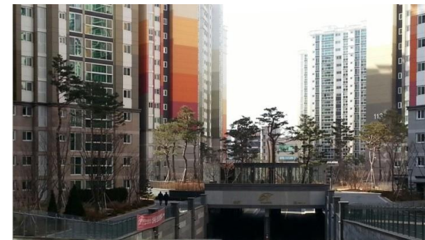
화곡3주구 재건축정비사업 • 소재지: 서울특별시 강서구 화곡동 • 세대수: 2,603
